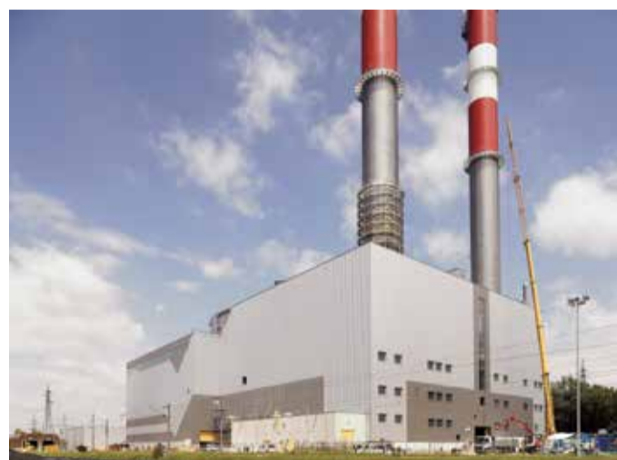
Das Gas-Kombikraftwerk der VERBUND Thermal Power in Mellach /Steiermark (Foto: VERBUND Thermal Power GmbH)
