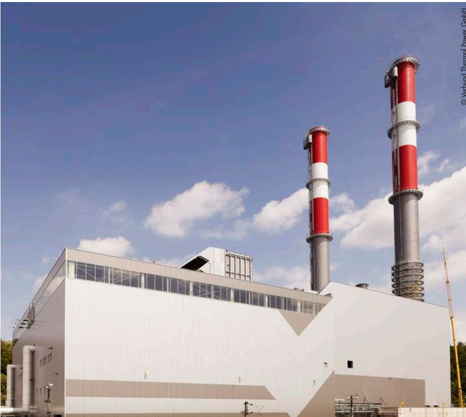
Abb. 1: Das Verbund-Gaskombikraftwerk Mellach ist ein hocheffizientes Wärmekraftwerk und ein Beispiel für optimalen Pumpeneinsatz bei schwierigen Förderprozessen.
